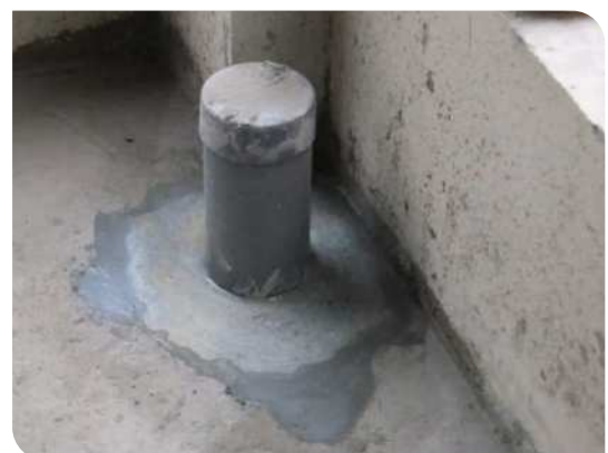
Bề mặt sau khi đổ vữa Grout
