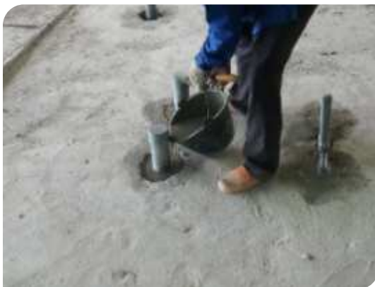
Thi công đổ vữa Grout
