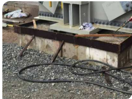
Lắp đặt ván khuôn
