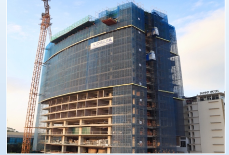
DỰ ÁN KHÁCH SẠN PÁC PỐ – CAO BẰNG Sân mái, Khu vệ sinh sử dụng Neoproof PU 360 / Revinex Flex FP Khối lượng: >15.000m 2
