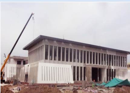
NHÀ MÁY KEYSHEEN – BẮC NINH Sân mái sử dụng Neoproof PU W Khối lượng: 5.300m 2 Sân vệ sinh sử dụng Revinex Flex FP Khối lượng: 890m 2
