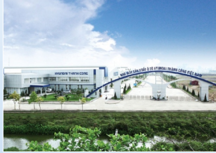
NHÀ MÁY HYUNDAI – NINH BÌNH Sàn mái sử dụng Neoproof PU W Khối lượng: 3.800m 2 Sàn vệ sinh sử dụng Neoproof PU 360 Khối lượng: 720m 2
