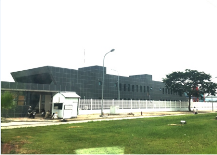
NHÀ MÁY LMS – HẢI DƯƠNG Sàn mái sử dụng Neoproof PU W Khối lượng: 1.987m 2
