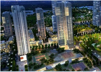
DỰ ÁN THE MANOR CENTRAL PARK – HÀ NỘI Sân vệ sinh sử dụng Neoproof PU 360 Khối lượng: 20.000m 2
