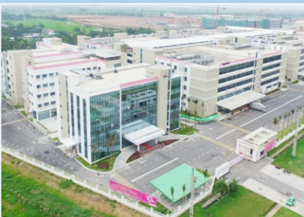
NHÀ MÁY REGINA MIRACLE INTERNATIONAL – HP Sân mái sử dụng Neoproof PU W Khối lượng: 18.000m 2
