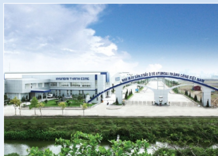
NHÀ MÁY HUYNDAI – NINH BÌNH Sân mái sử dụng Neoproof PU W Khối lượng: 3.800m 2 Sân vệ sinh sử dụng Neoproof PU 360 Khối lượng: 720m 2
