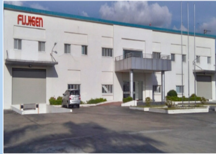
NHÀ MÁY FUJIGEN – BẮC NINH Sàn mái sử dụng Neoproof PU W Khối lượng: 2.700m 2
