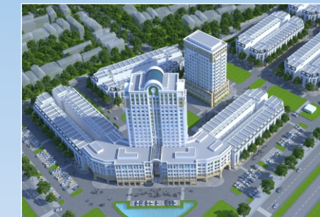
DỰ ÁN TỔ HỢP NHÀ Ở MỚI – THANH HÓA Sân mái sử dụng Neoproof PU W Khối lượng: 5.700m 2
