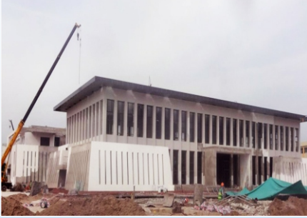
NHÀ MÁY KEYSHEEN – BẮC NINH Sàn mái sử dụng Neoproof PU W Khối lượng: 5.300m 2 Sàn vệ sinh sử dụng Revinox Flex FP Khối lượng: 890m 2
