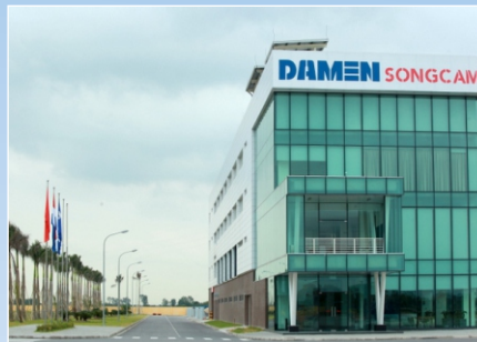
NHÀ MÁY DAMEN SÔNG CẨM – HẢI PHÒNG Sân mái sử dụng Neoproof PU W Khối lượng: 20.000m 2
