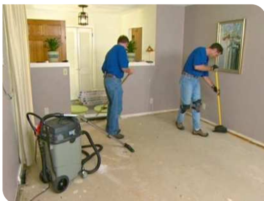
Vệ sinh bề mặt
