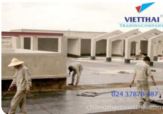
Thi công màng khò nóng
