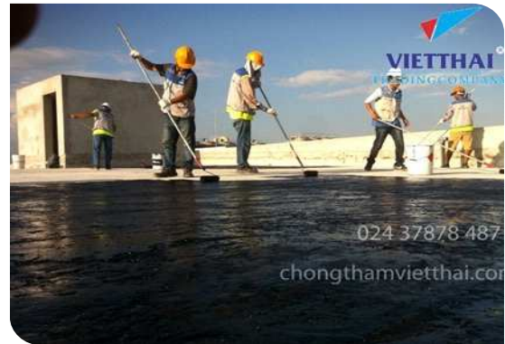
Thi công lăn lớp lót
