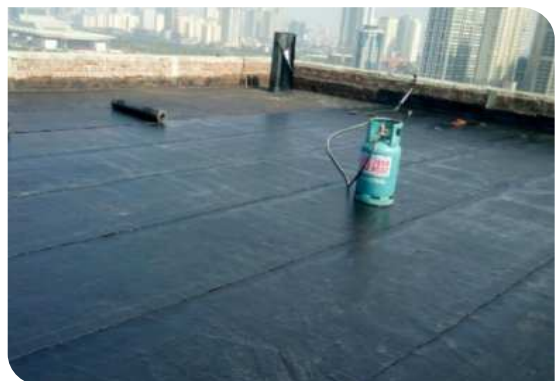
Bề mặt hoàn thiện
