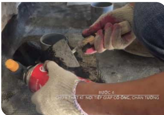
Xử lý cổ ống thoát nước
