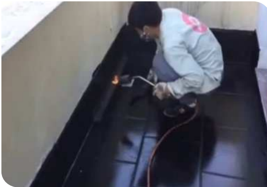
Xử lý góc chân tường
