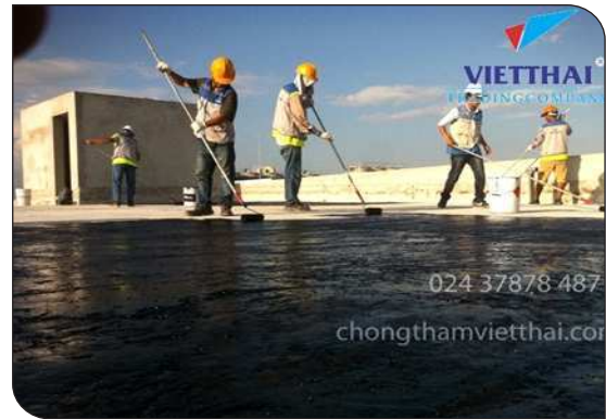
Thi công lăn lớp lót
