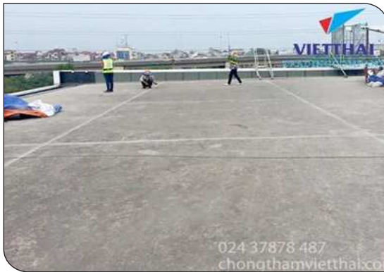
Chuẩn bị bề mặt
