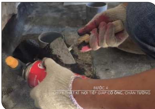
Xử lý cổ ống thoát nước
