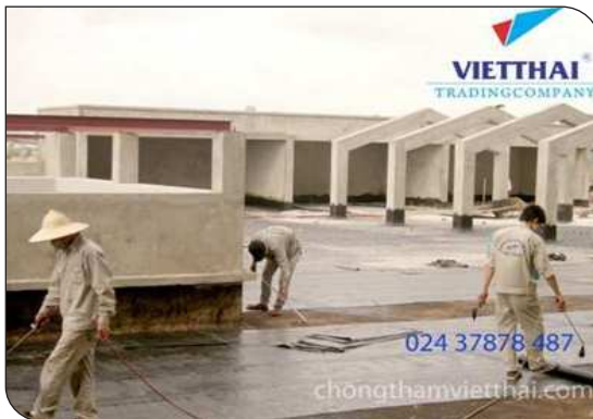
Thi công màng khô nóng
