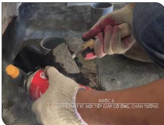
Xử lý cổ ống thoát nước
