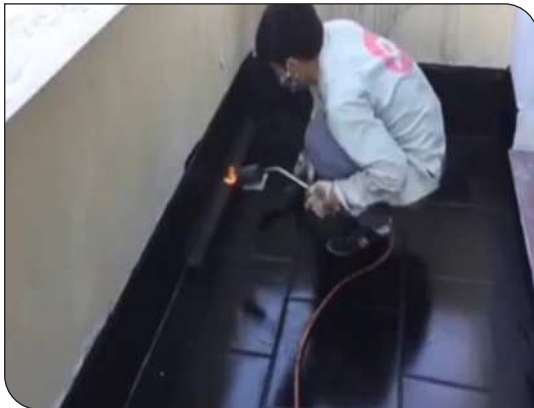
Xử lý góc chân tường
