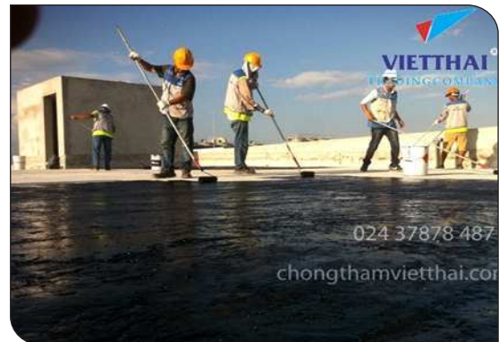
Thi công lăn lớp lót
