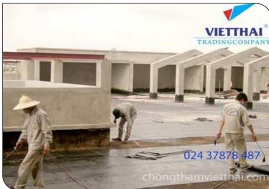
Thi công màng khô nóng
