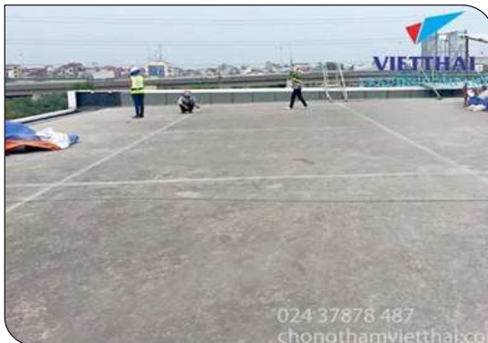
Chuẩn bị bề mặt
