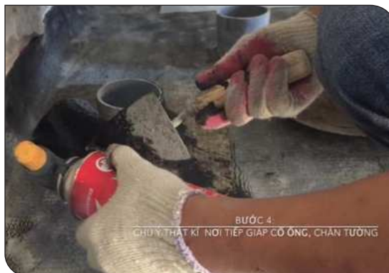
Xử lý cổ ống thoát nước
