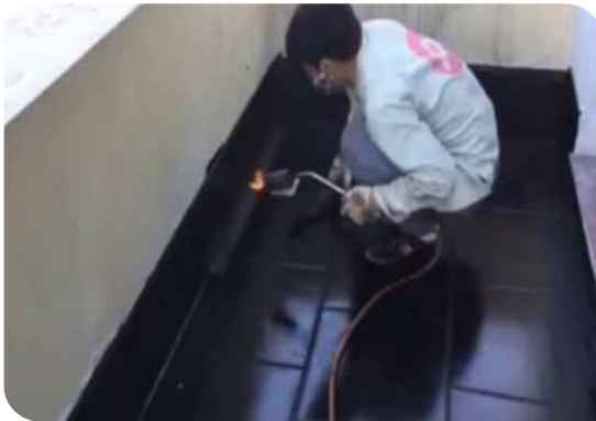
Xử lý góc chân tường
