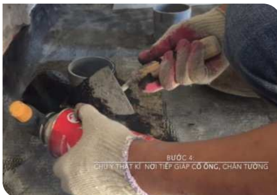
Xử lý cổ ống thoát nước
