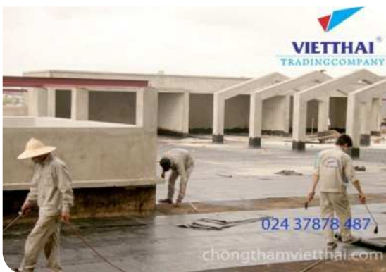
Thi công màng khô nóng
