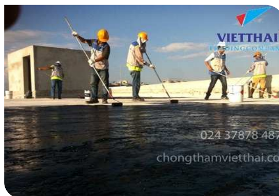
Thi công lăn lớp lót
