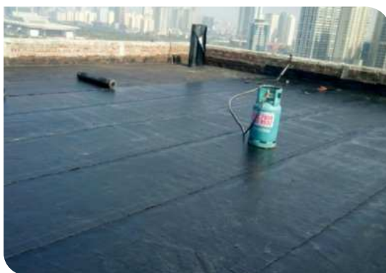
Bề mặt hoàn thiện
