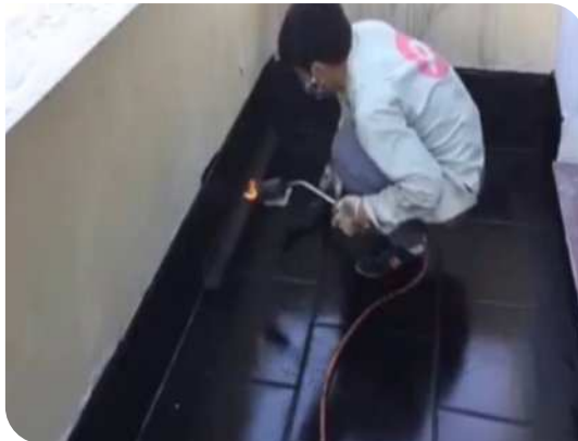
Xử lý góc chân tường
