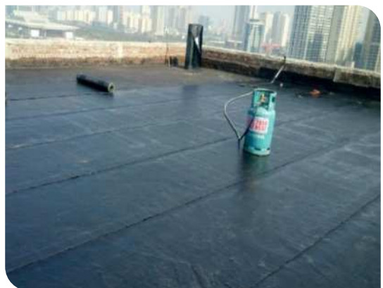
Bề mặt hoàn thiện
