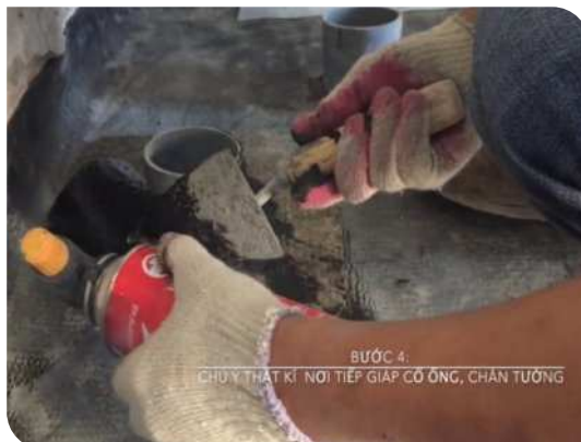
Xử lý cổ ống thoát nước
