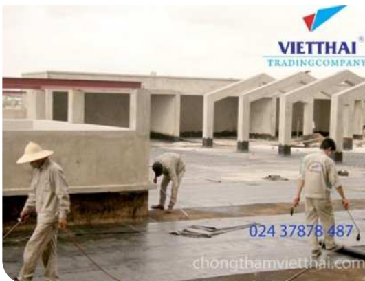
Thi công màng khô nóng
