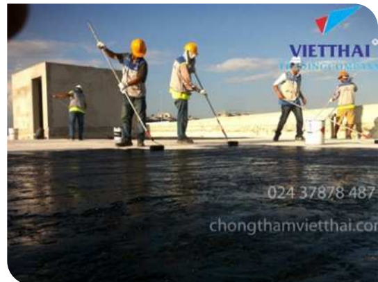
Thi công lăn lớp lót
