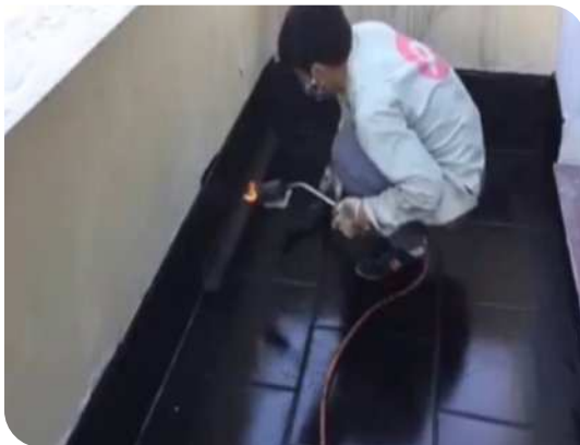
Xử lý góc chân tường
