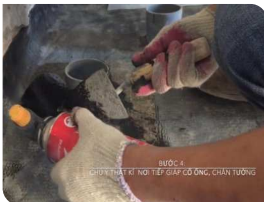
Xử lý cổ ống thoát nước
