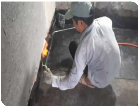
Thi công màng khô nóng
