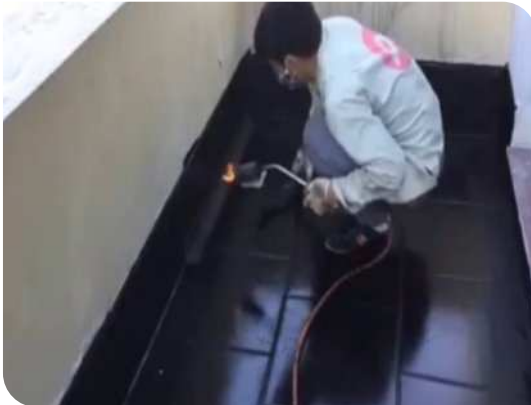
Xử lý góc chân tường
