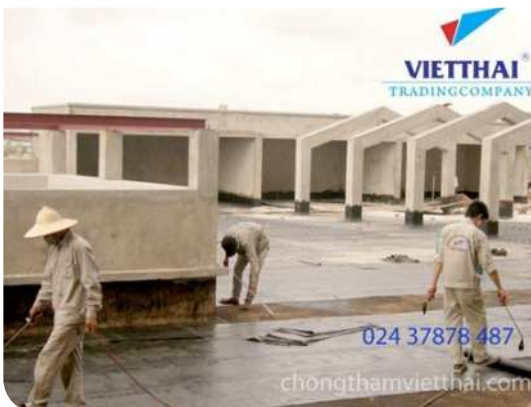
Thi công màng khô nóng
