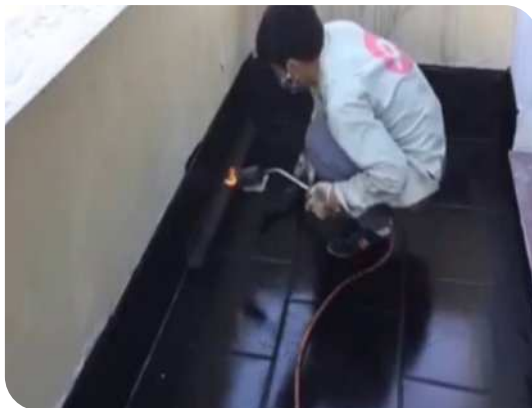
Xử lý góc chân tường
