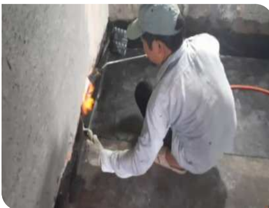
Thi công màng khô nóng
