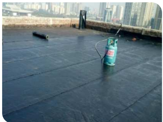
Bề mặt hoàn thiện
