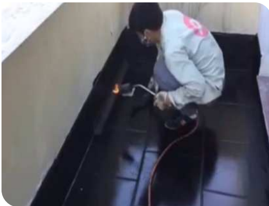
Xử lý góc chân tường
