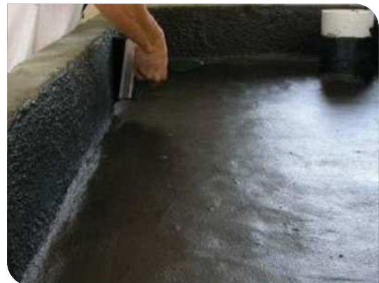
Thi công lăn lớp lót
