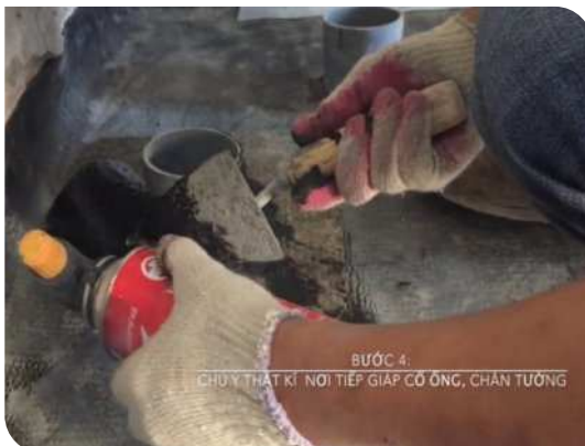
Xử lý cổ ống thoát nước
