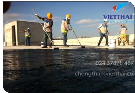
Thi công lăn lớp lót
