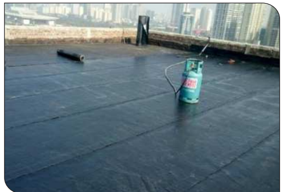
Bề mặt hoàn thiện
