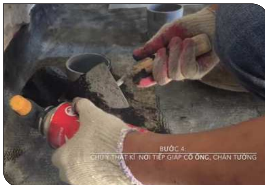
Xử lý cổ ống thoát nước
