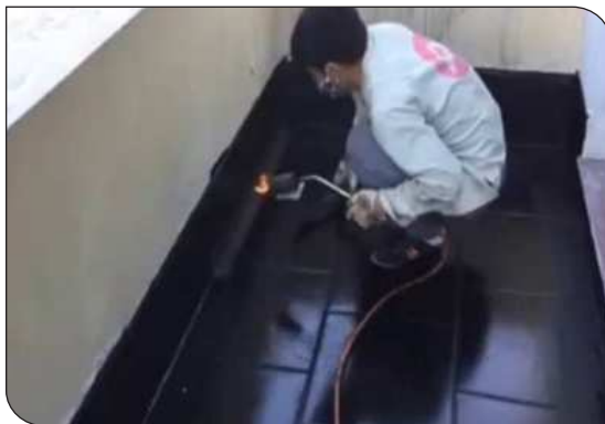
Xử lý góc chân tường
