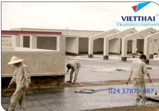
Thi công màng khò nóng
