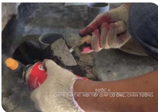
Xử lý cổ ống thoát nước
