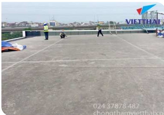
Chuẩn bị bề mặt
