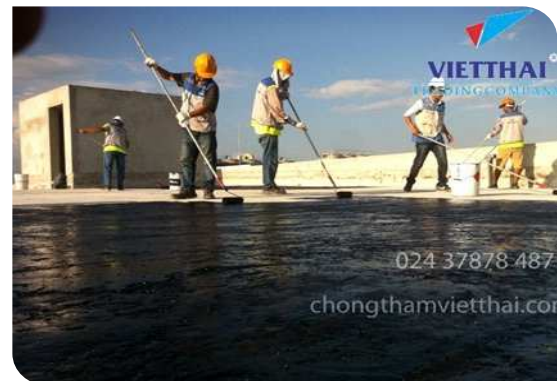
Thi công lăn lớp lót
