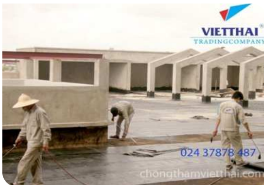
Thi công màng khò nóng
