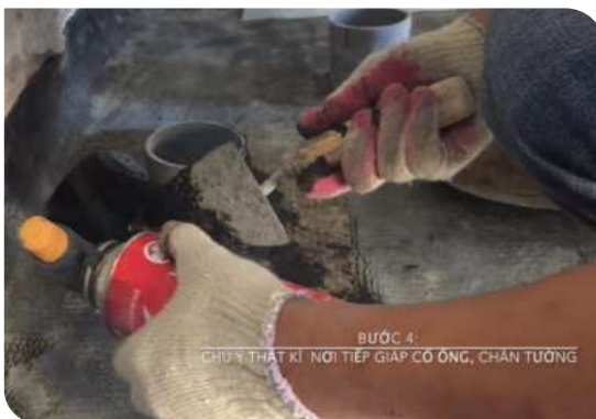
Xử lý cổ ống thoát nước
