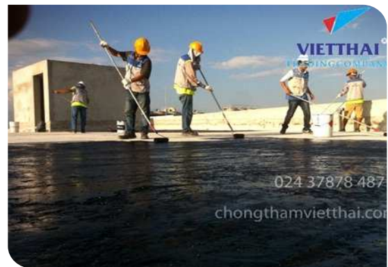
Thi công lăn lớp lót
