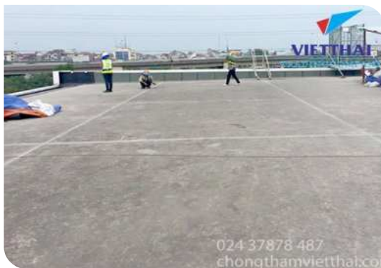
Chuẩn bị bề mặt
