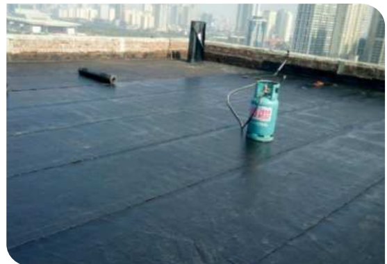
Bề mặt hoàn thiện
