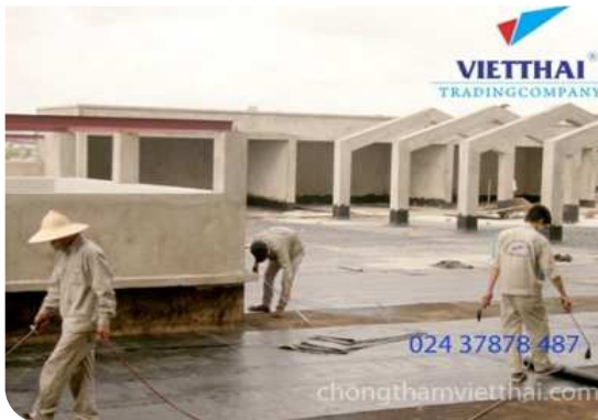
Thi công màng khô nóng
