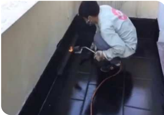
Xử lý góc chân tường
