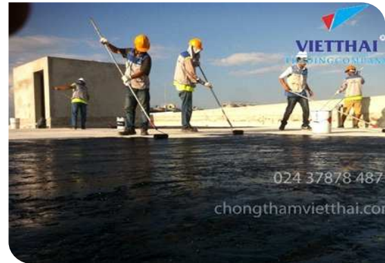
Thi công lăn lớp lót
