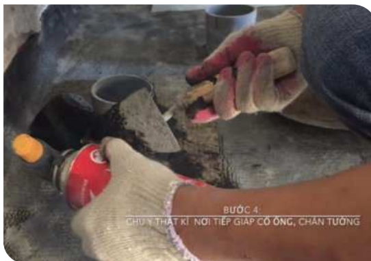
Xử lý cổ ống thoát nước
