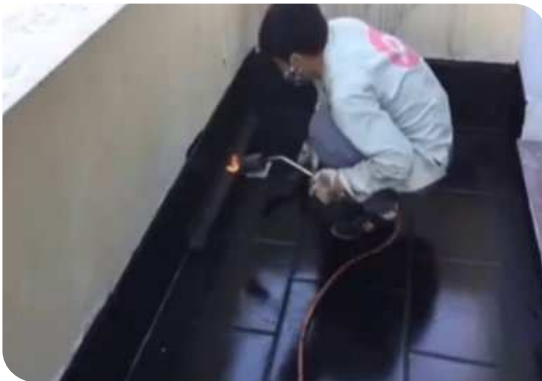
Xử lý góc chân tường
