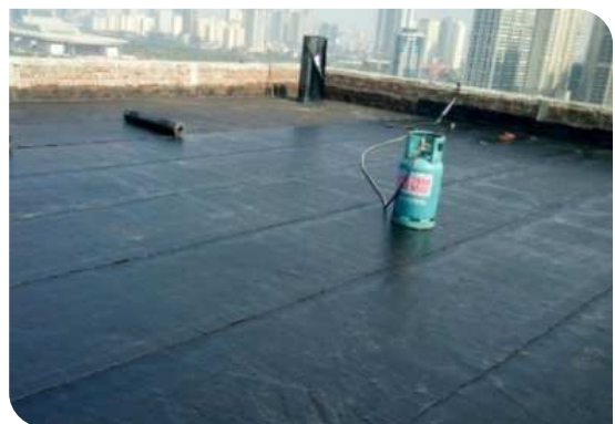
Bề mặt hoàn thiện
