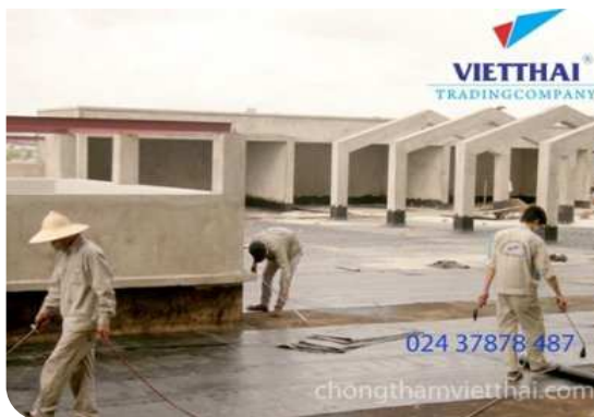
Thi công màng khò nóng
