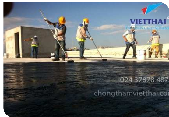
Thi công lăn lớp lót
