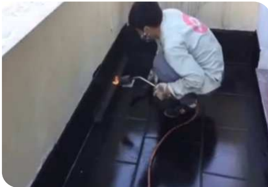
Xử lý góc chân tường
