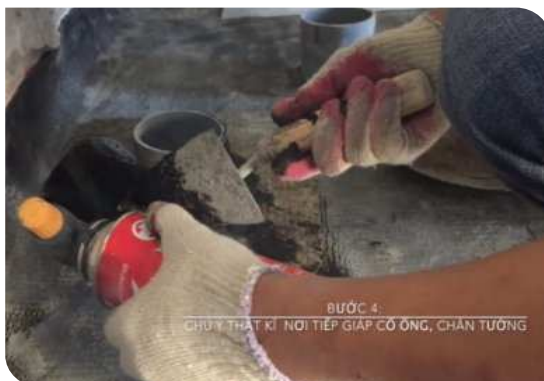
Xử lý cổ ống thoát nước
