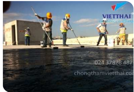
Thi công lăn lớp lót
