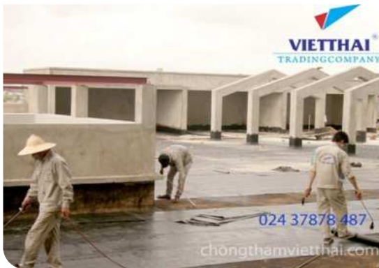
Thi công màng khô nóng
