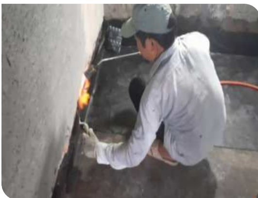
Thi công màng khò nóng
