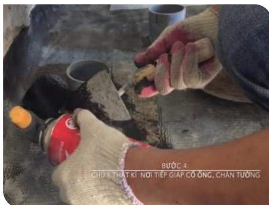
Xử lý cổ ống thoát nước
