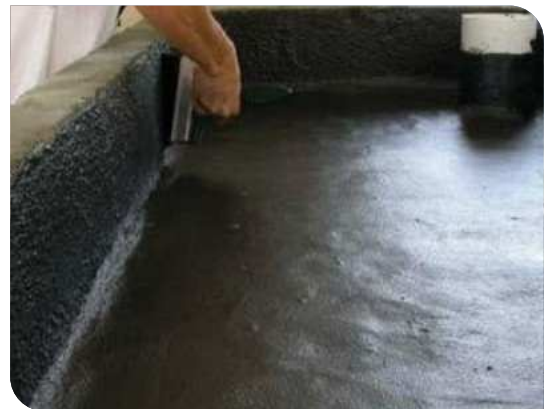
Thi công lăn lớp lót
