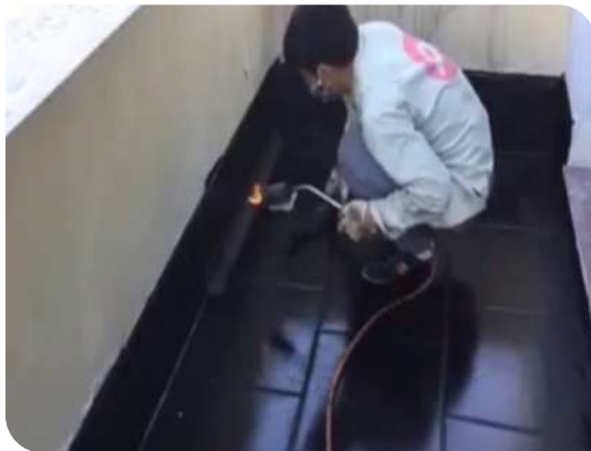
Xử lý góc chân tường
