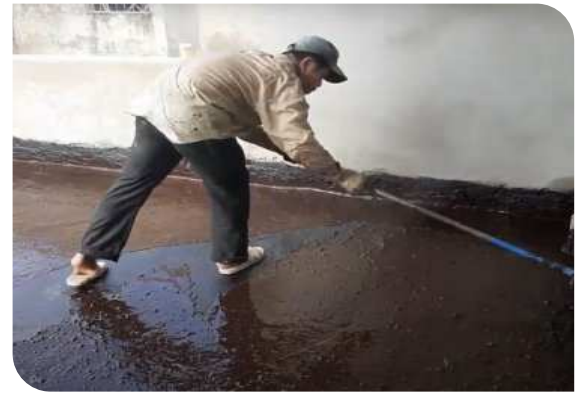
Thi công lăn lớp lót
