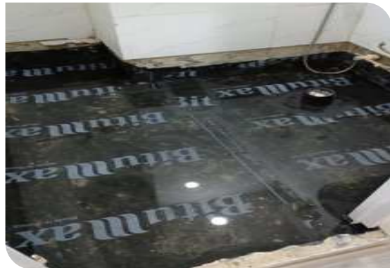
Thi công màng tự dính
