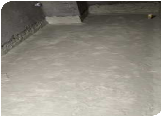
Chuẩn bị bề mặt
