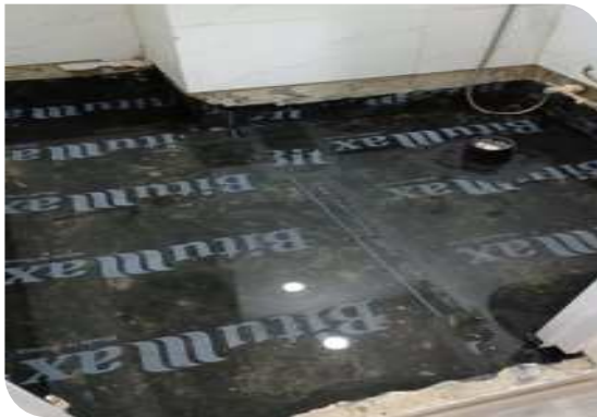
Thi công màng tự dính
