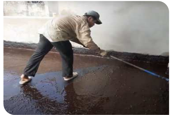
Thi công lăn lớp lót
