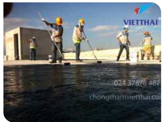
Thi công lăn lớp lót
