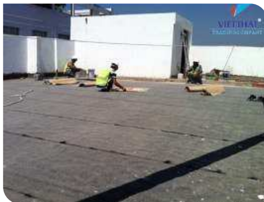
Thi công màng tự dính
