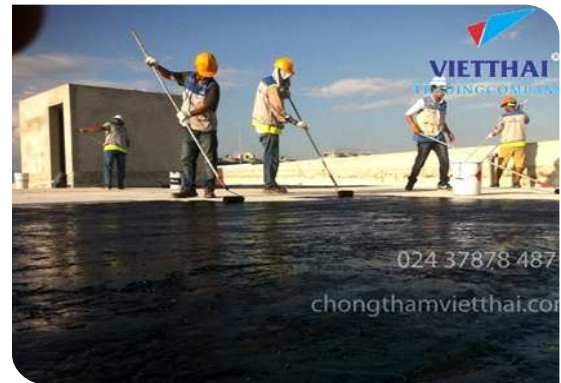
Thi công lăn lớp lót
