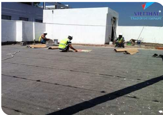
Thi công màng tự dính
