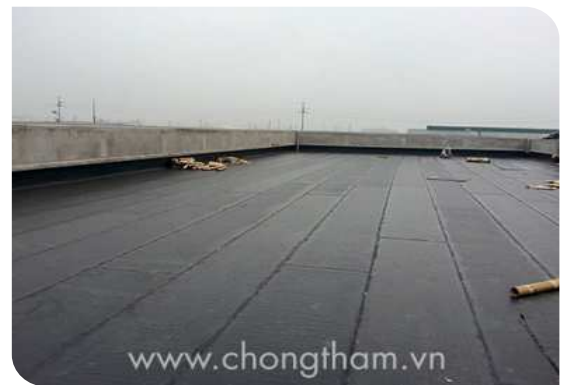
Bề mặt hoàn thiện
