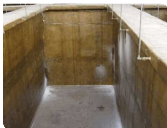
Thi công lớp lót
