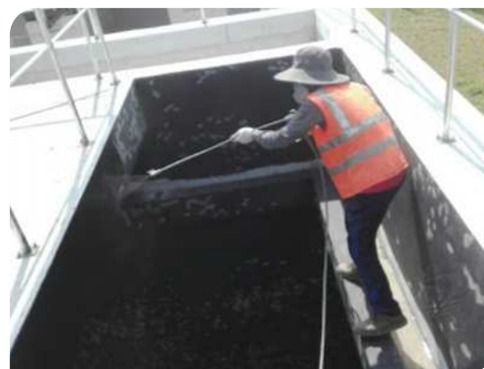
Thi công lớp 2
