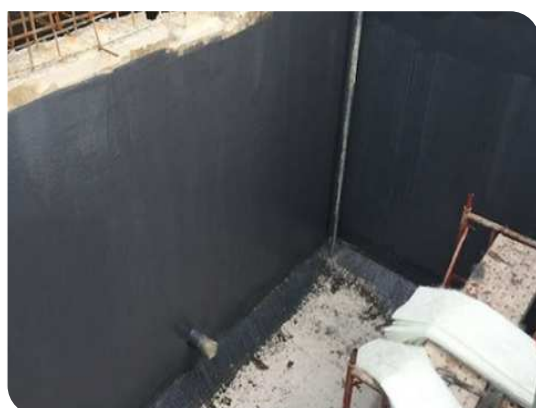
Thi công lớp 1
