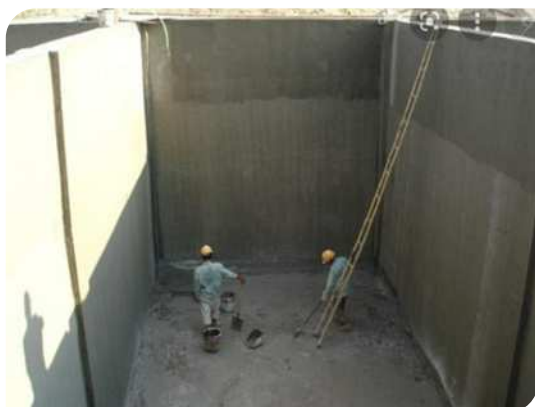
Vệ sinh chuẩn bị bề mặt
