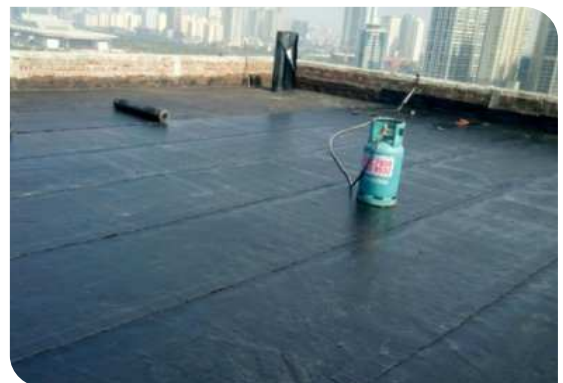
Bề mặt hoàn thiện
