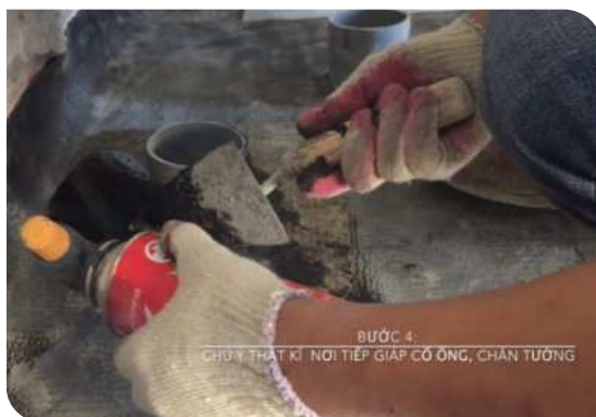
Xử lý cổ ống thoát nước
