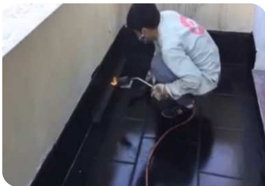
Xử lý góc chân tường
