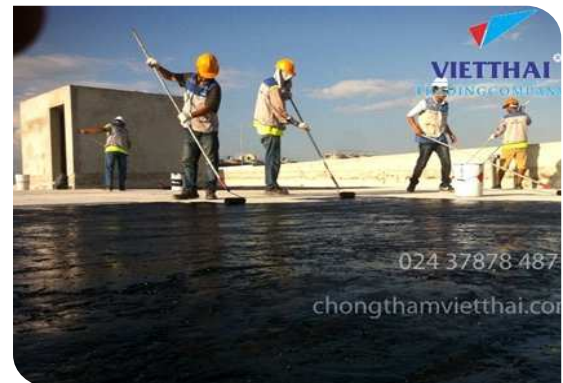
Thi công lăn lớp lót
