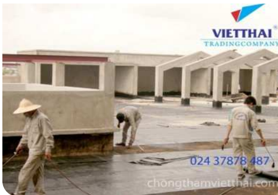
Thi công màng khò nóng
