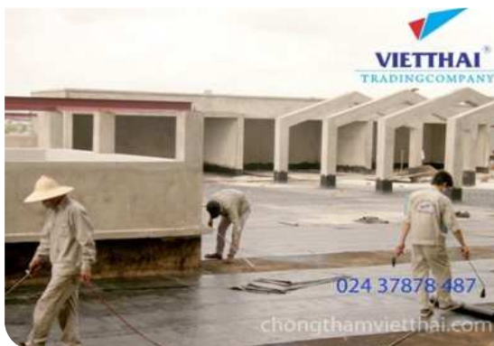
Thi công màng khò nóng
