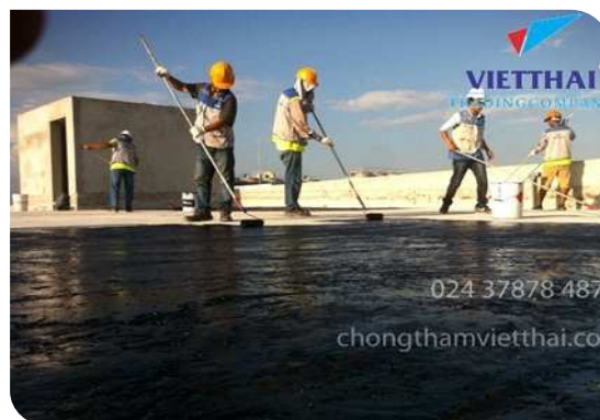
Thi công lăn lớp lót
