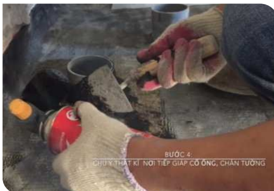
Xử lý cổ ống thoát nước
