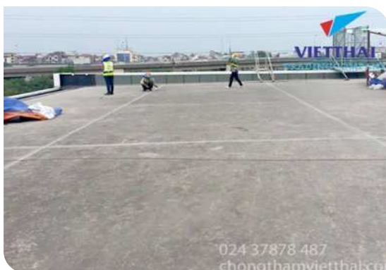
Chuẩn bị bề mặt
