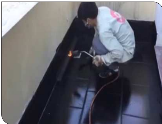
Xử lý góc chân tường
