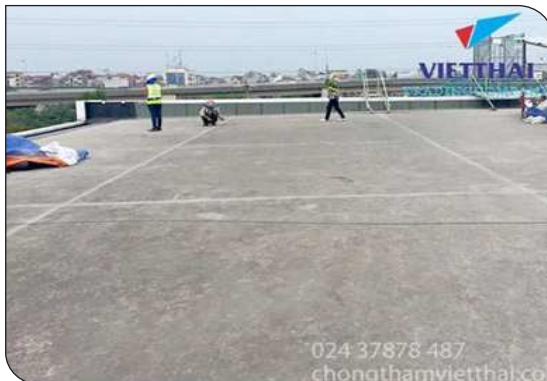
Chuẩn bị bề mặt
