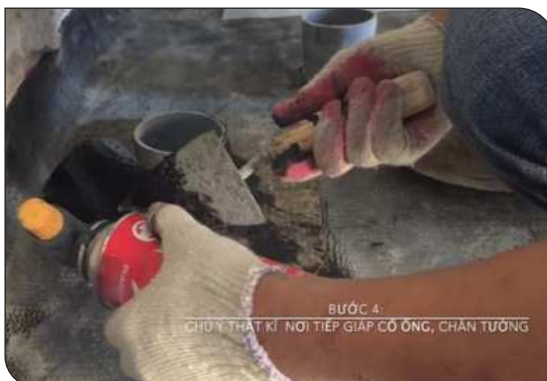
Xử lý cổ ống thoát nước
