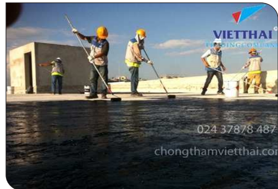
Thi công lăn lớp lót
