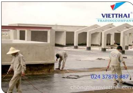
Thi công màng khô nóng
