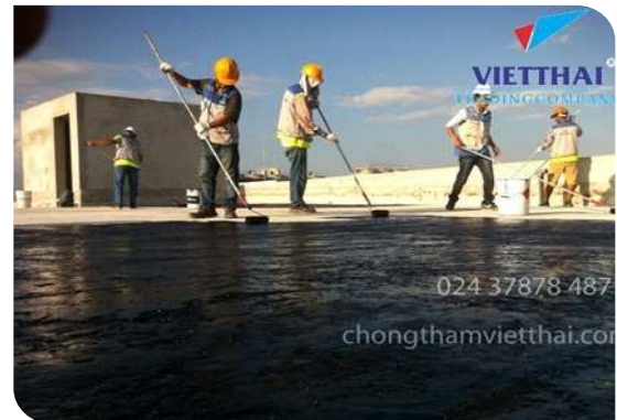
Thi công lăn lớp lót
