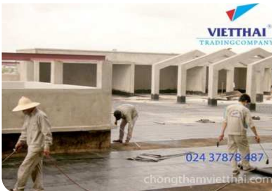
Thi công màng khô nóng
