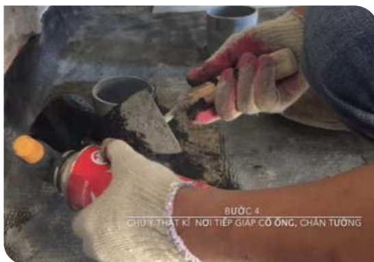
Xử lý cổ ống thoát nước
