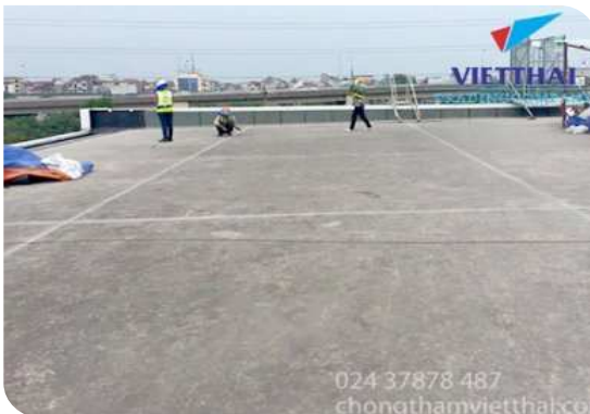
Chuẩn bị bề mặt
