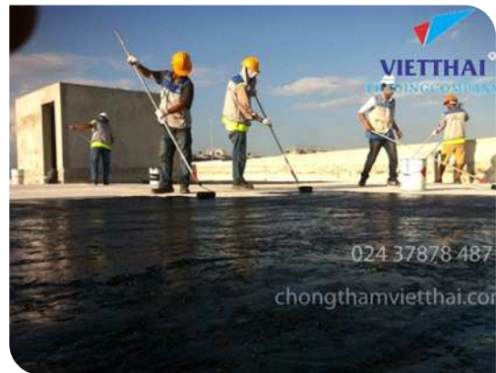
Thi công lăn lớp lót
