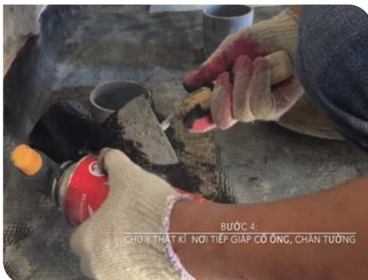
Xử lý cổ ống thoát nước
