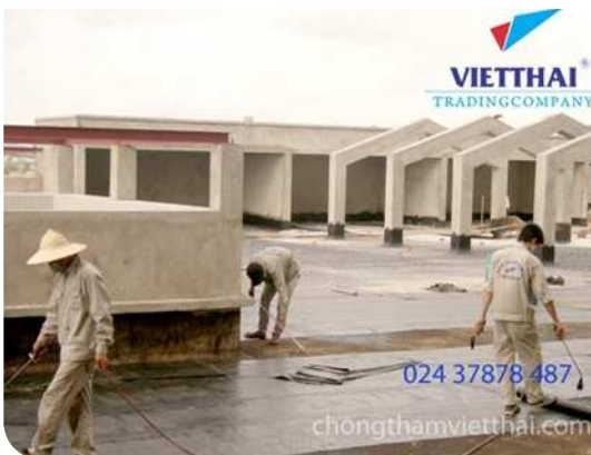
Thi công màng khô nóng
