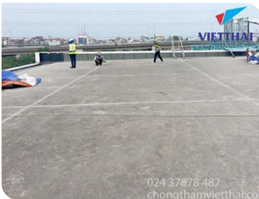
Chuẩn bị bề mặt
