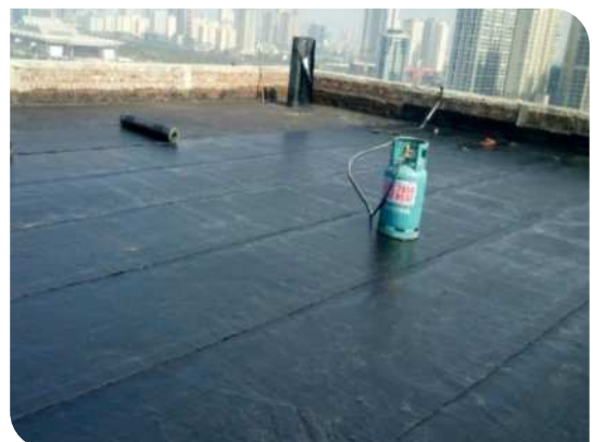
Bề mặt hoàn thiện
