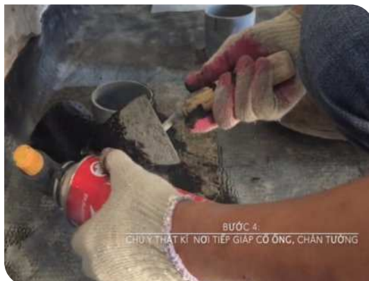
Xử lý cổ ống thoát nước
