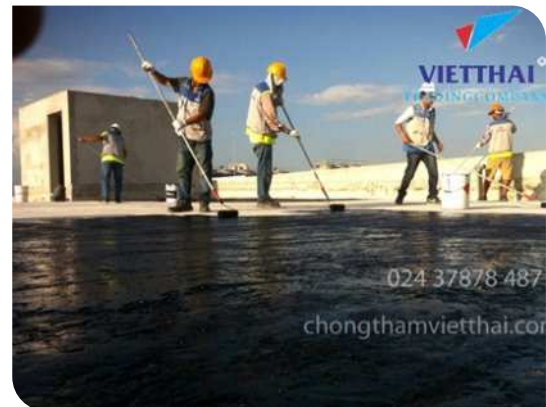
Thi công lăn lớp lót
