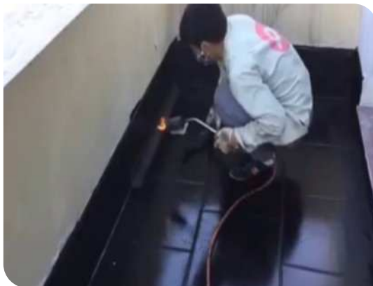
Xử lý góc chân tường
