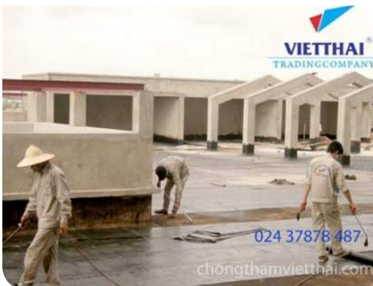
Thi công màng khô nóng
