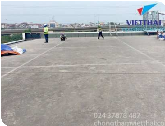
Chuẩn bị bề mặt
