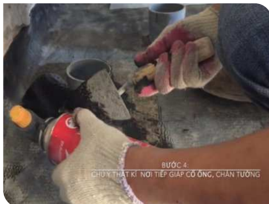
Xử lý cổ ống thoát nước
