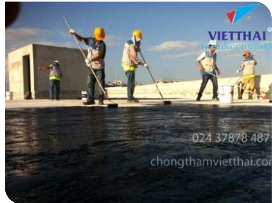
Thi công lăn lớp lót
