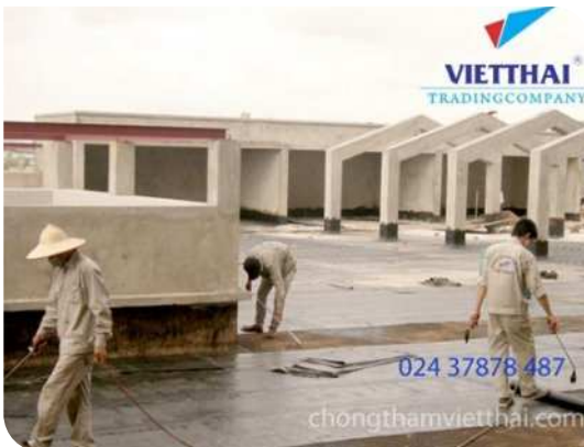
Thi công màng khô nóng
