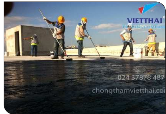
Thi công lăn lớp lót
