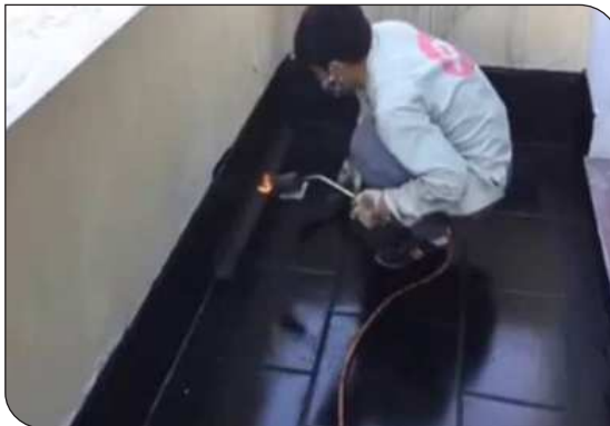
Xử lý góc chân tường
