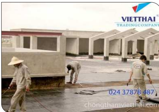
Thi công màng khò nóng
