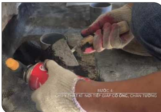
Xử lý cổ ống thoát nước
