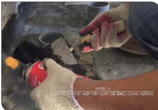
Xử lý cổ ống thoát nước
