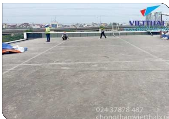
Chuẩn bị bề mặt
