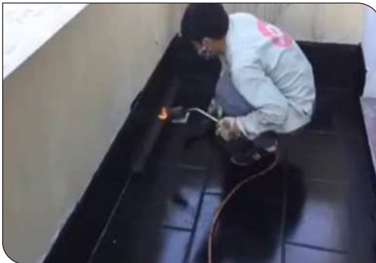
Xử lý góc chân tường
