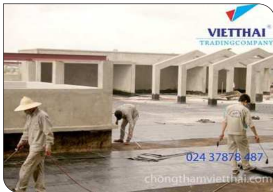
Thi công màng khò nóng
