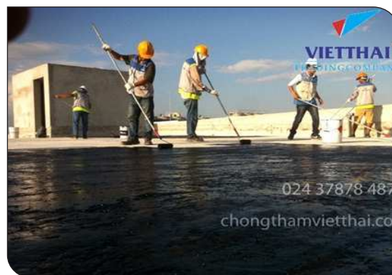
Thi công lăn lớp lót
