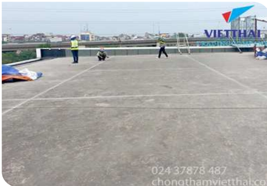
Chuẩn bị bề mặt
