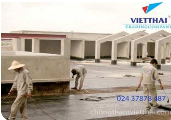
Thi công màng khô nóng
