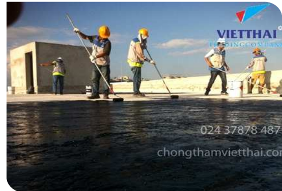
Thi công lăn lớp lót
