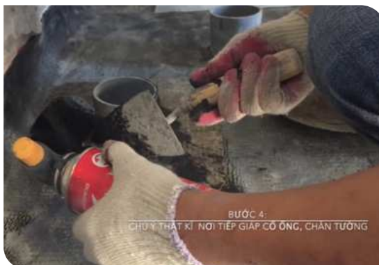
Xử lý cổ ống thoát nước
