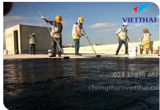
Thi công lăn lớp lót
