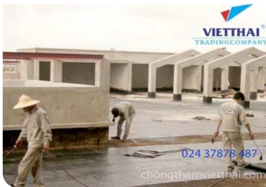
Thi công màng khô nóng
