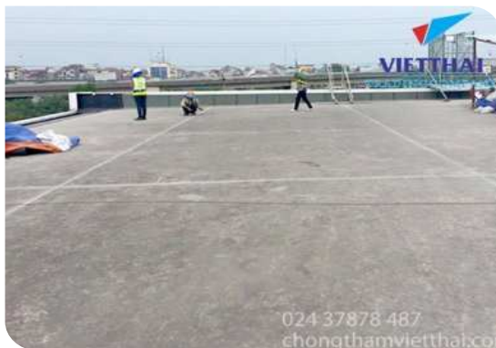
Chuẩn bị bề mặt
