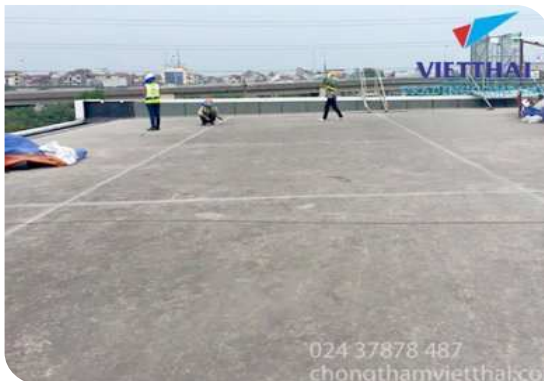
Chuẩn bị bề mặt
