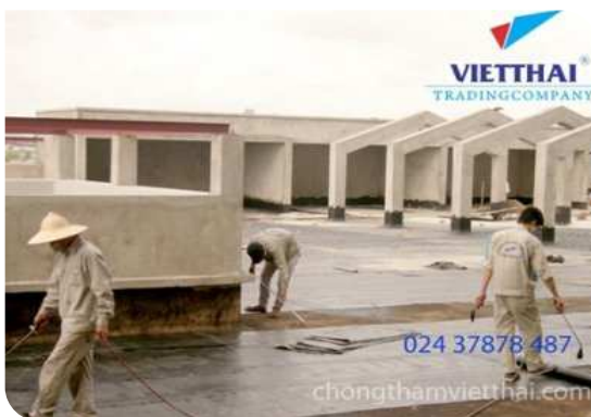
Thi công màng khô nóng
