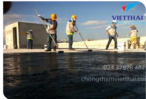
Thi công lăn lớp lót
