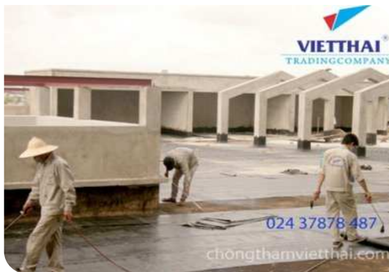
Thi công màng khô nóng
