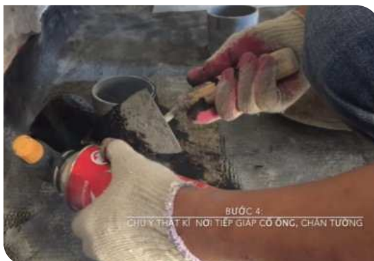
Xử lý cổ ống thoát nước
