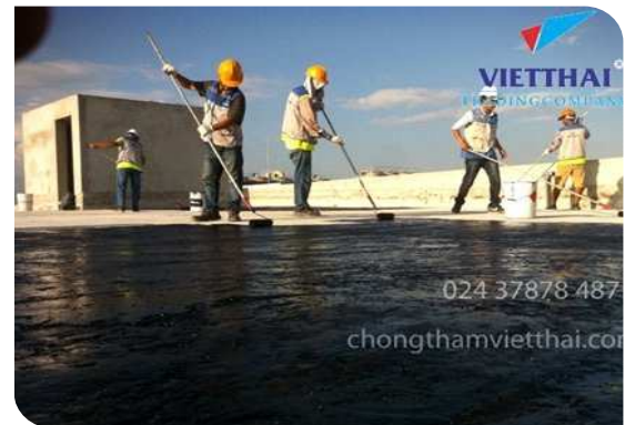
Thi công lăn lớp lót
