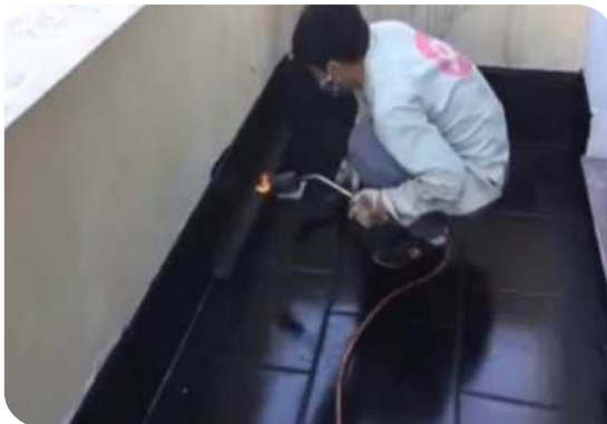
Xử lý góc chân tường
