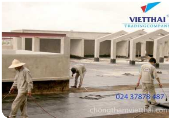
Thi công màng khô nóng
