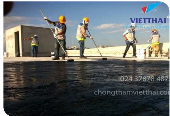
Thi công lăn lớp lót
