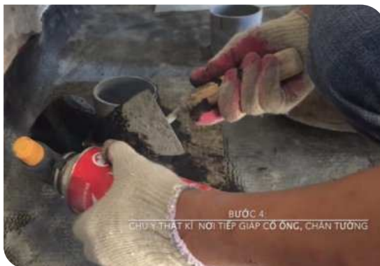
Xử lý cổ ống thoát nước
