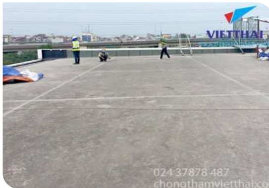
Chuẩn bị bề mặt
