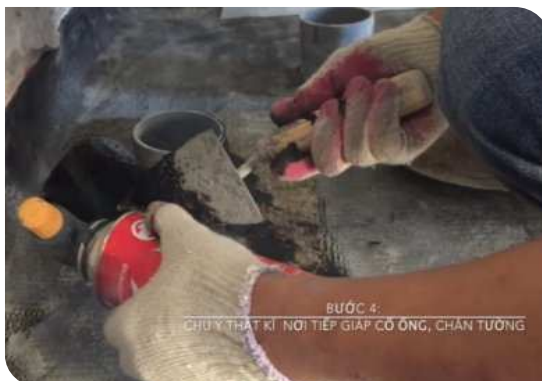
Xử lý cổ ống thoát nước
