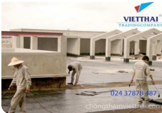
Thi công màng khô nóng
