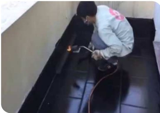
Xử lý góc chân tường
