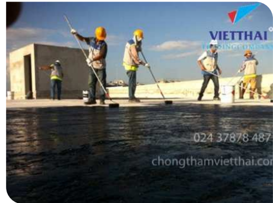
Thi công lăn lớp lót
