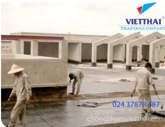
Thi công màng khô nóng
