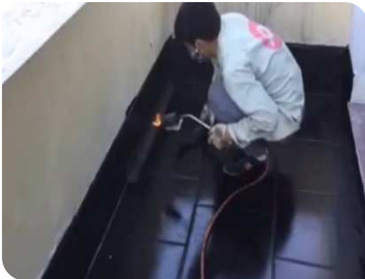
Xử lý góc chân tường
