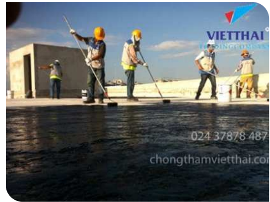
Thi công lăn lớp lót
