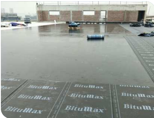
Thi công màng tự dính
