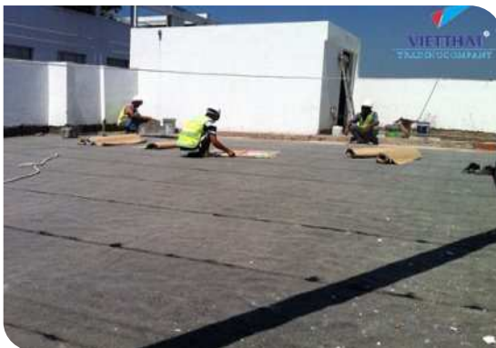
Thi công màng tự dính
