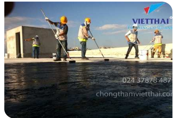
Thi công lăn lớp lót
