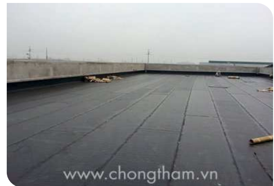
Bề mặt hoàn thiện
