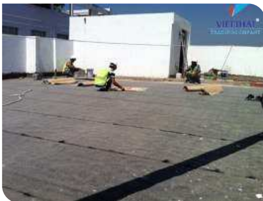
Thi công màng tự dính
