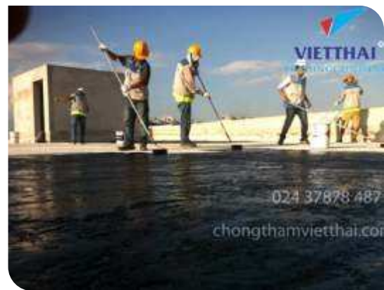
Thi công lăn lớp lót
