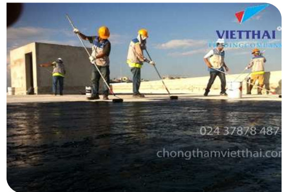
Thi công lăn lớp lót
