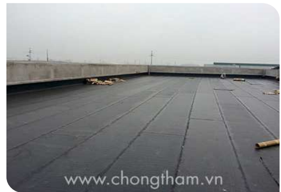
Bề mặt hoàn thiện
