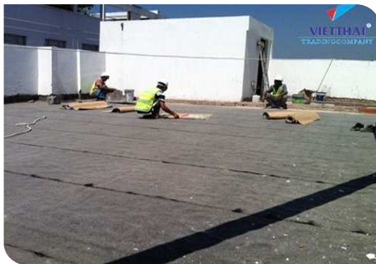
Thi công màng tự dính
